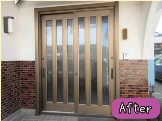
今ある枠の上から新しい枠を取り付けるカバー工法を用い、網戸付きの断熱玄関引き戸に交換。夏は虫の侵入を防げるだけでなく、風の通りも良くなり、快適に過ごせます。
