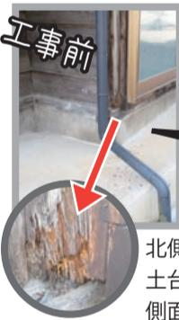
北側の外柱が劣化していました。土台はまだ使えるので柱の側面から補強しました。
