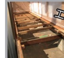
根太(床下の木材)を補強して、床の沈みを直します。断熱材ももちろん入れます。お母さまのお気に入りの縁側がピカピカに。
