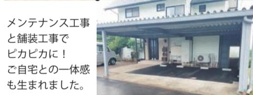
天井の断熱材(パフ)が剥がれてきており、見た目も悪くなってきていました。傷んだ断熱材を全て削り取り、新しく結露防止剤を吹き付けました。鉄骨部分は塗装をし直しました。また、インターロッキングとコンクリートの間の土の部分は、アスファルトで舗装し車輪止めを設置して完成です。
