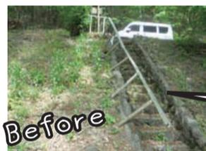
別荘までのアプローチの石段の木製手摺が、劣化し倒れていました。アルミ製の手摺に交換し、安全に通行できるようになりました。
