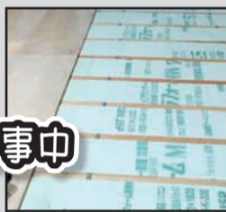
居室床はしっかりと断熱材を入れて、床からの冷えを防止！
