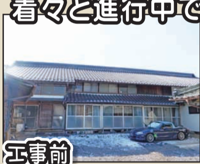
工事前 小諸市 Y様邸 前はベース床工事の様子までご紹介しました。今回は設備や電気の配線工事、窓や勝手口ドアのサッシ設置工事となります。
