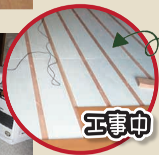
工事前 合板フローリング→合板フローリング 昔流行った、市松柄のフローリングは経年劣化で傷んでおりました。断熱改修し、新しい合板フローリングに張り替えました。
