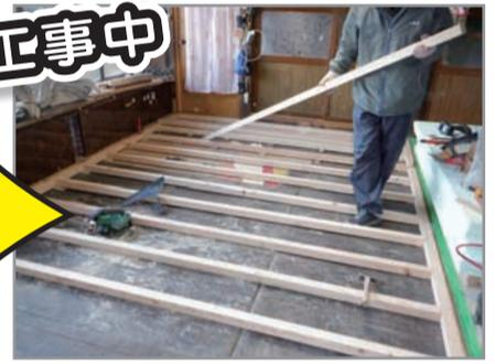
床板全体のビス止めを行い、フローリング張りの下地材を入れていきます。この時に下地材を調整しながら水平にしていきます。
