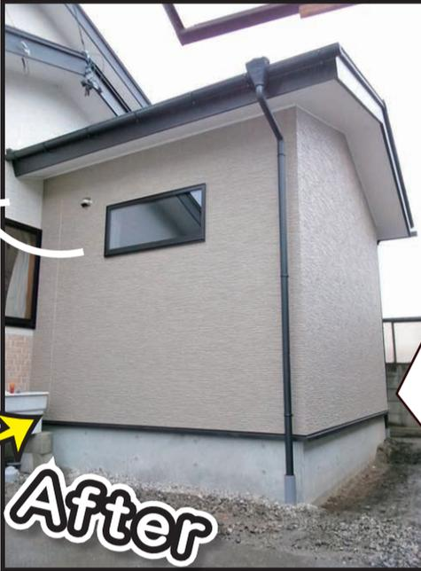
キッチンの奥に増築してお子様の部屋を作りたいとのご希望でした。外壁を撤去し、基礎から新たに造りました。ピアノを置く予定と伺いましたのでピアノの荷重に耐えられるよう基礎・土台を増やして施工しました。また室内には造作カウンター・本棚・クローゼットも作りました。
