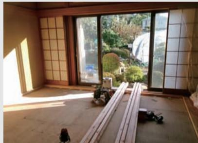
畳を撤去して掘りごたつを塞ぎ、根太を施工していきます。
